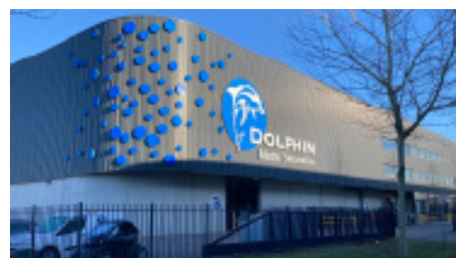
Dolphin Metal Separation in Harderwijk haalt herbruikbare metalen uit reststoffen. Beeld Evert Jan de Kort
